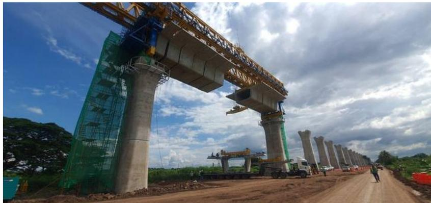
2021年5月29日，中泰铁路首孔40米节段预制简支箱梁—颂嫩特大桥101#梁顺利架设，标志着中泰铁路建设取得重要进展。（图片来源：中国日报）
